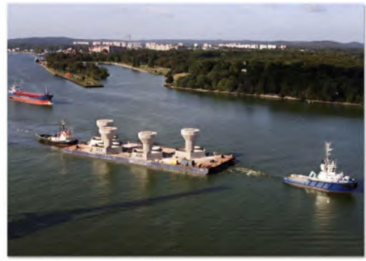
1.2.1 pav. VE pamatų konstrukcijų transportavimas (nuotraukos iš Jeppsson et al. 2008).
