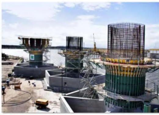
1.2.1 pav. VE pamatų konstrukcijų transportavimas (nuotraukos iš Jeppsson et al. 2008).
