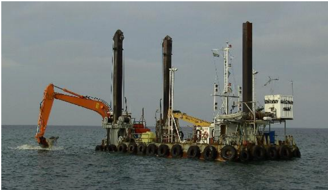
1.2.4 pav. Dugno paruošimas jūrinio kabelio klojimui (nuotrauka iš Jeppsson et al. 2008).
