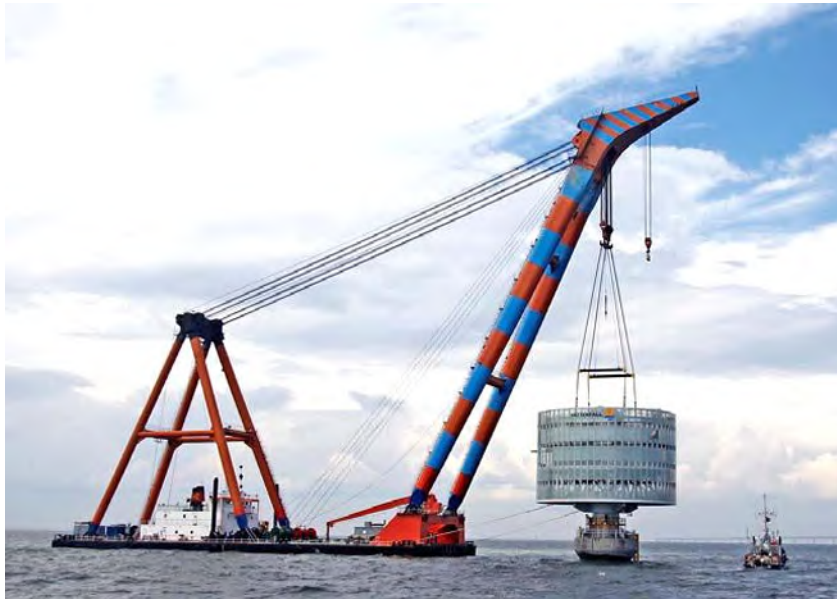
1.2.5 pav. Elektros pastotės montavimas Lillgrund VE parke (nuotrauka iš Jeppsson et al. 2008).
