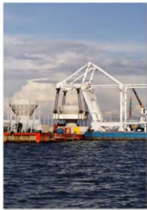
1.2.3 pav. VE pamatų konstrukcijų montavimas jūroje (nuotraukos iš Jeppsson et al. 2008).
