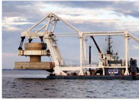
1.2.3 pav. VE pamatų konstrukcijų montavimas jūroje (nuotraukos iš Jeppsson et al. 2008).
